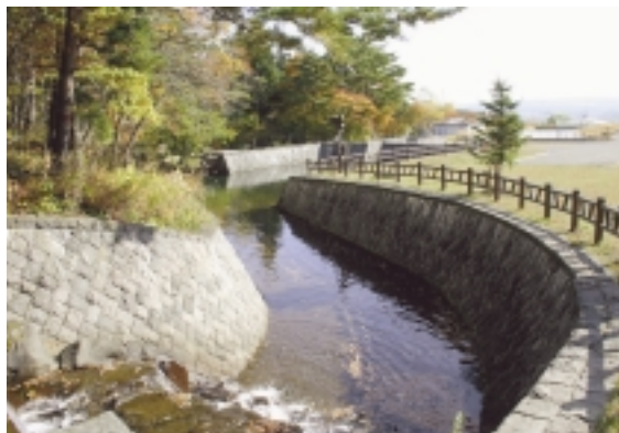
上水道管理センター（小荒川取水口）
