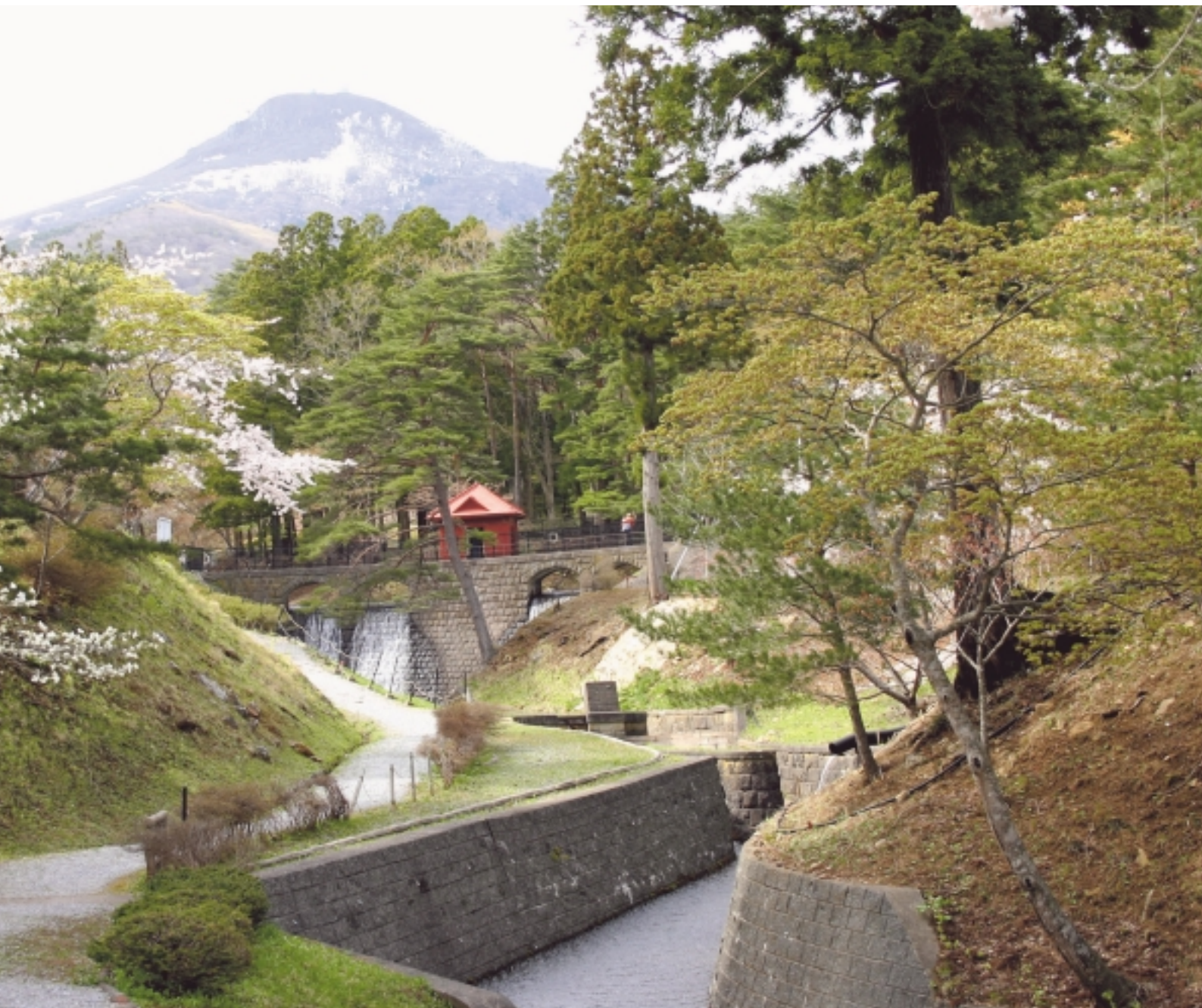
大湊第一水源地（厚アーチ式堰堤） ※平成17年5月撮影
