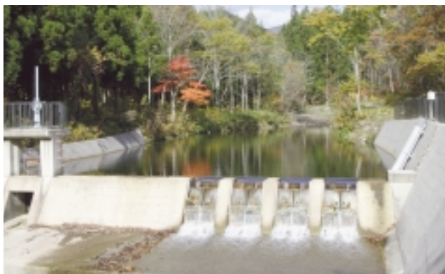
永下水源地（永下川取水口）
