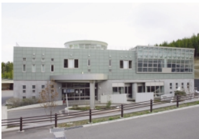
上水道管理センター（H11年竣工）
