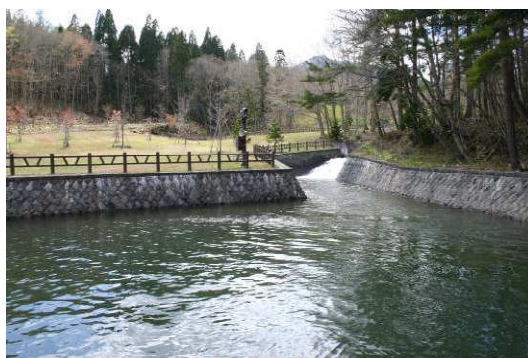
荒川浄水場取水口上流(小荒川)
