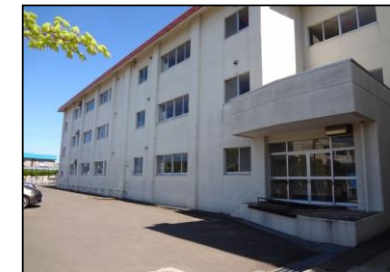
大畑小学校北棟(現況)
