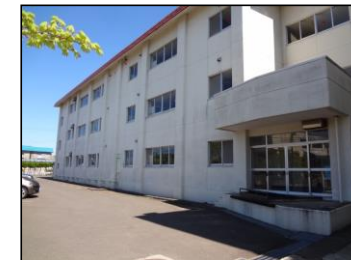
大畑小学校北棟(現況)
