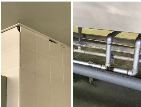
むつ中学校給食室（壁面損傷・配管錆び）
