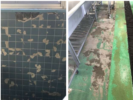
第二田名部小学校給食室（壁面・床面損傷）
