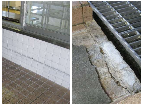
苫生小学校給食室（壁面・床面損傷）
