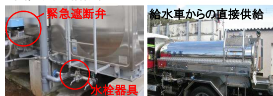
図. 受水槽設置イメージ
