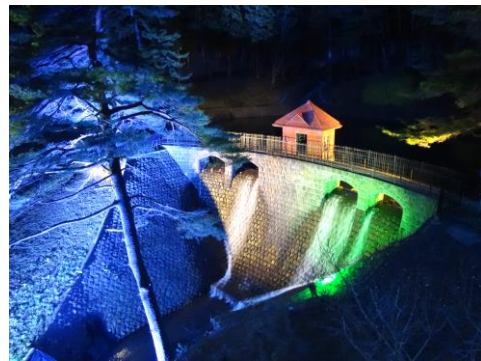
水源地公園沈澄池堰堤
