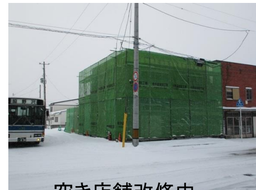
空き店舗改修中
