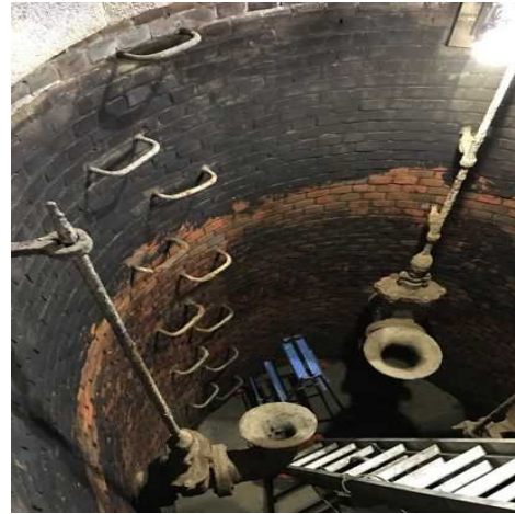
重要文化財保存修理事業（旧大湊水源地道施設） 乙水槽内部の様子（保存状態が良好であることが判明）
