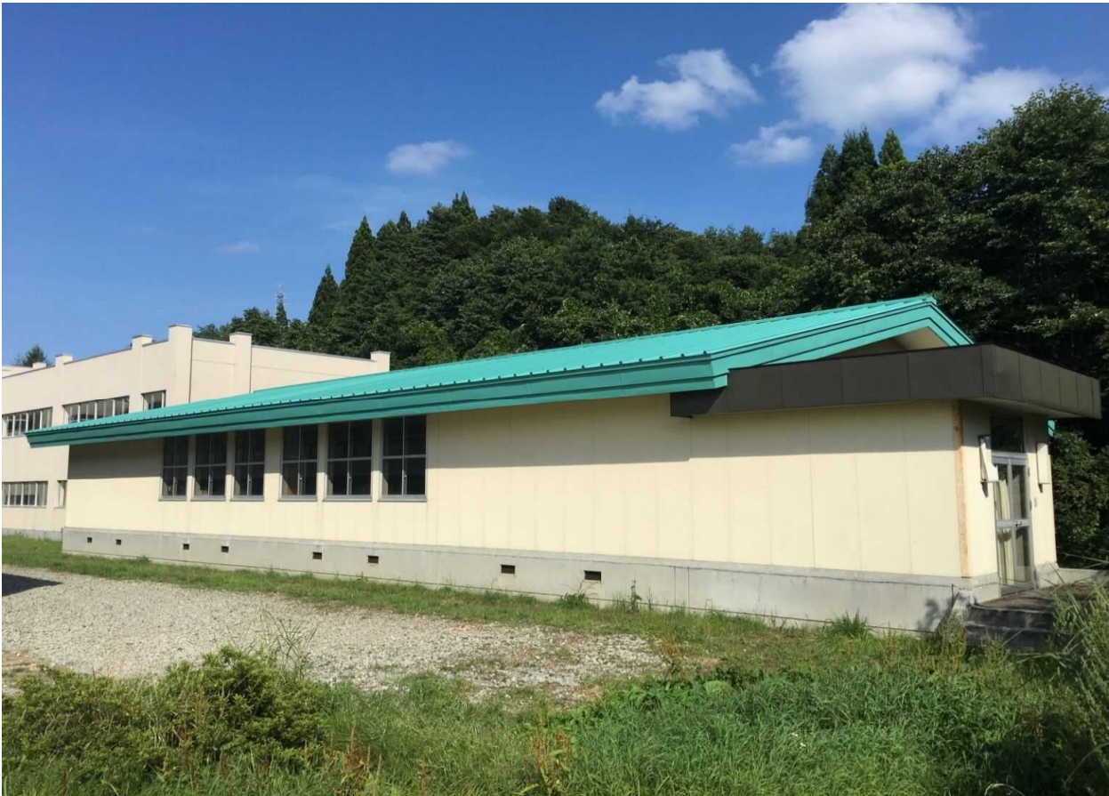
大畑中学校柔剣道場屋根改修工事後
